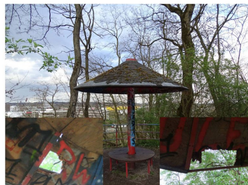
Bild 1: Der Sitzpilz auf der Knappenhalde mit eingefügten Detailansichten der Beschädigungen. Im Hintergrund das Sicherungsgeländer.
