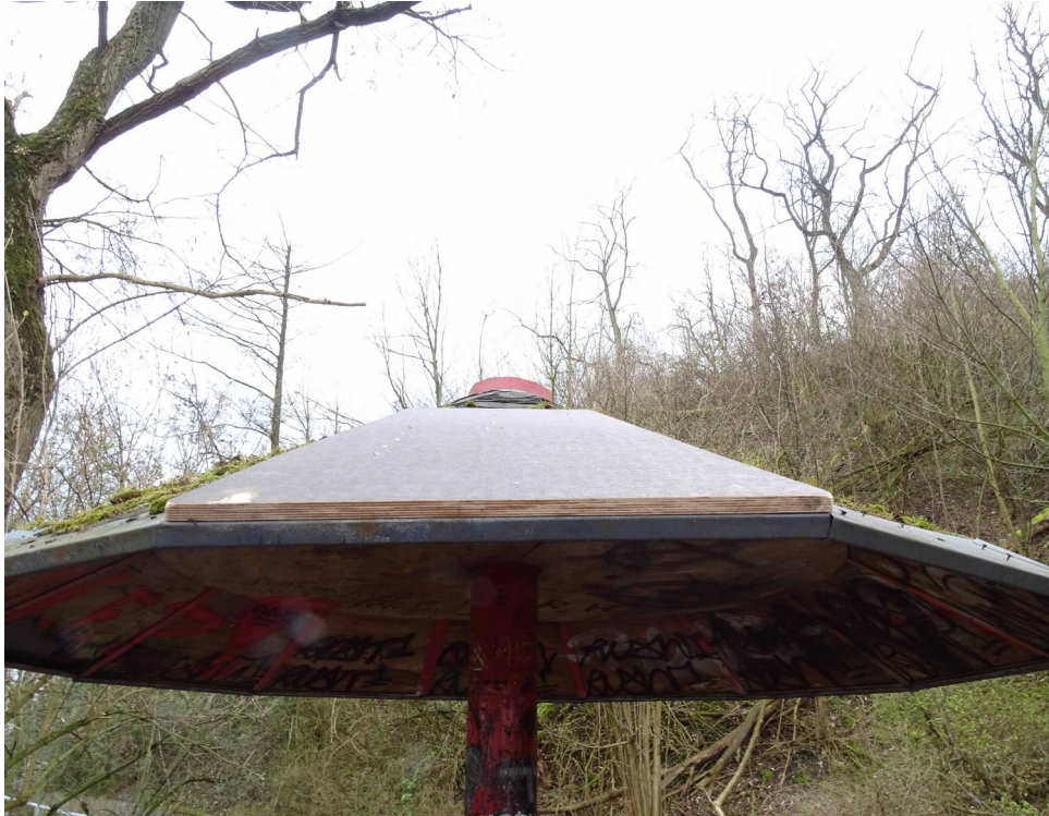
Ausbesserungen am Dach des Sitzpilzes (Aufnahme vom 14. 3. 2021).
