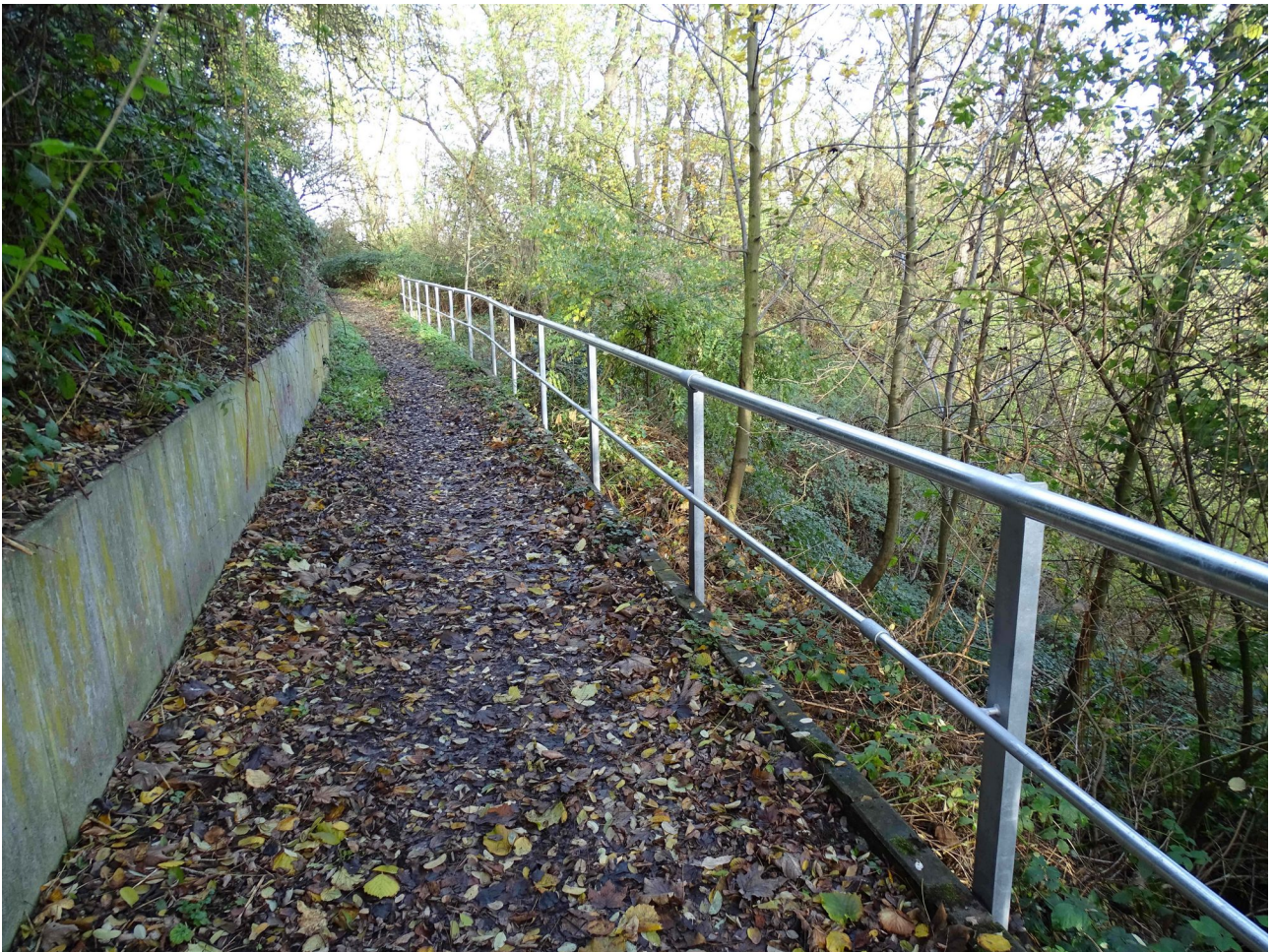
Ausgebesserte Geländer (Mitte November 2021).
