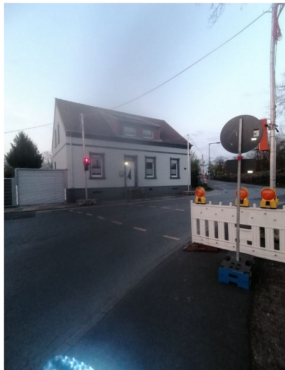
Bild 3: Auf der anderen Straßenseite liegt der Übergang von der Bebelstraße (Hintergrund) zur Kerwerstraße.
