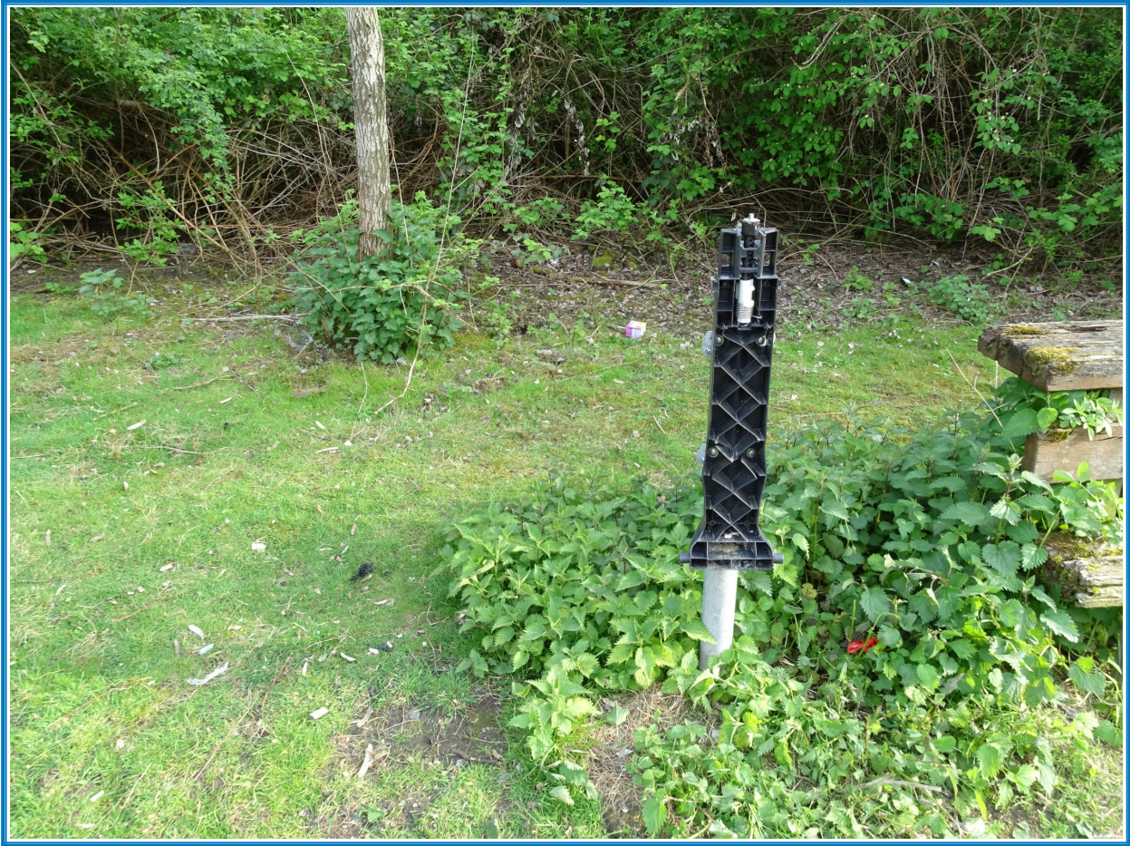
Ansicht des Bereiches, in dem ein Müllbehälter infolge von Vandalismusschäden fehlt.
