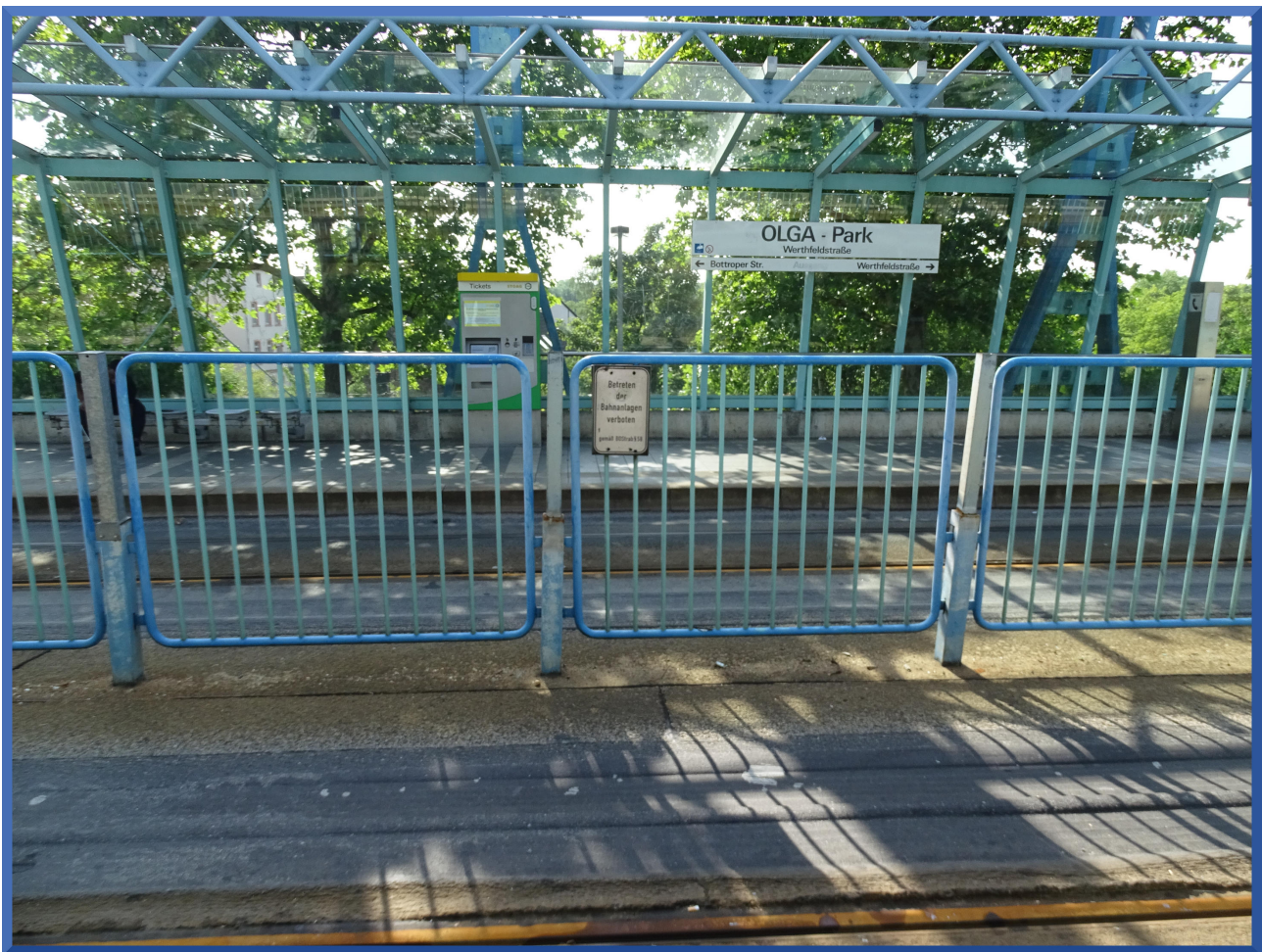
Bild 1: Haltestelle OLGA-Park: Ein hohes Trenngitter macht ein Überqueren der Fahrspuren unmöglich. Nach diesem Muster sollen weitere Haltestellen nachgerüstet werden.
